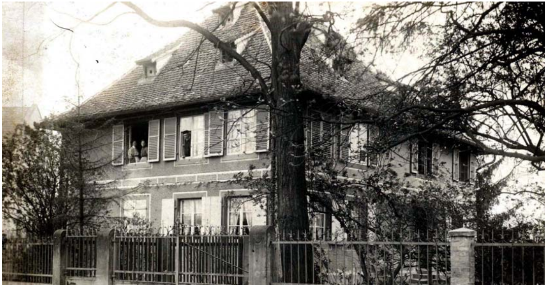
Le presbytère protestant était une maison dont le colombage avait été recouvert d'un crépi, vétuste, il a été démoli en 1962 et remplacé par un nouveau
