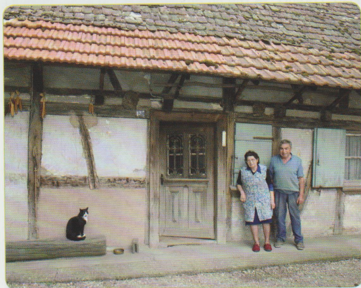
Photo prise en 2010 avant les travaux avec nos grands-parents Godefroi et Henriette Fischer
