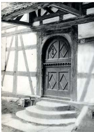
Sur le linteau, la date de 1700
