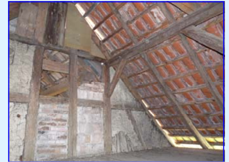
Ancienne charpente avant rénovation.
