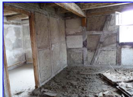
Démontage des lambris et coffrages.
