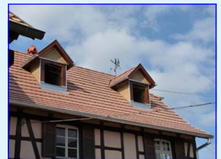
Nouvelle charpente et ouvertures.
